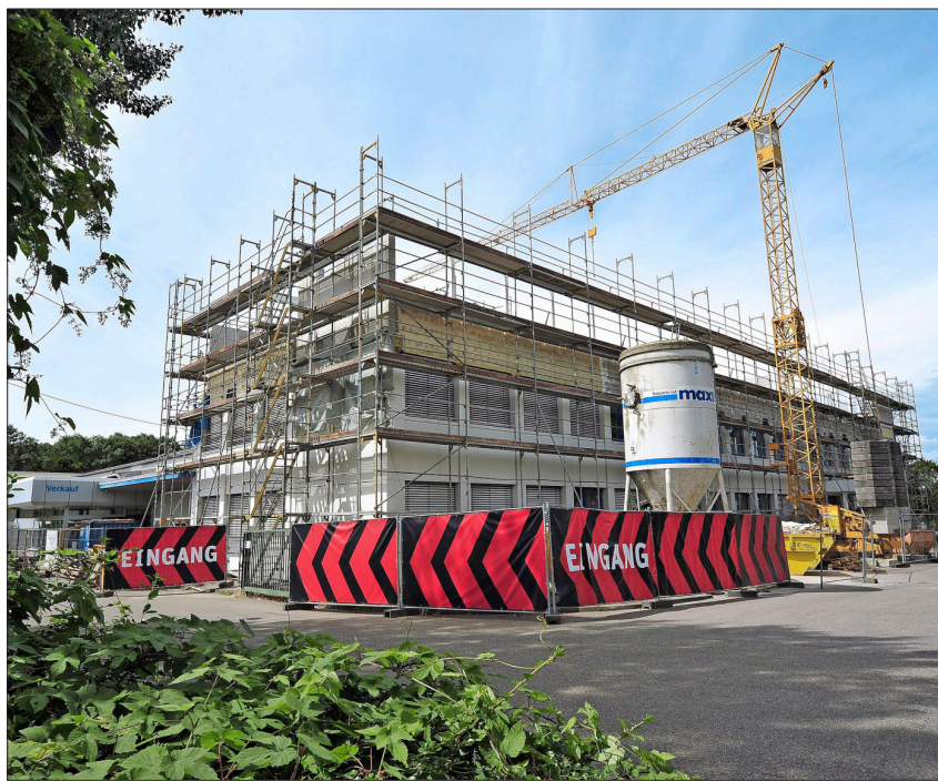
Um zwei Etagen wächst derzeit das 1972 bezogene Schafferer-Haus im Industriegebiet Nord in die Höhe.
